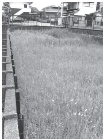
整備前の貯水池
